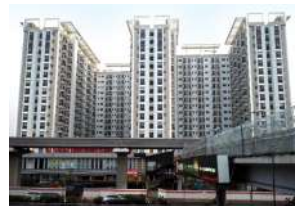
Proyek : Signature Park Grande Owner : Pikko Group Maincon : Pulauiantan BPK
