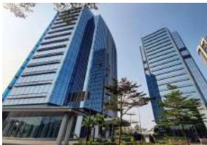
Proyek : Ciputra International Owner : Ciputra Maincon : Nusa Konstruksi Enjiniring, Tbk.
