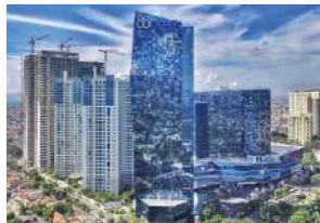
Proyek : Casa Grande @Kota Kasablanka Owner : Pakuwon Maincon : JO, Lotte - Totalindo
