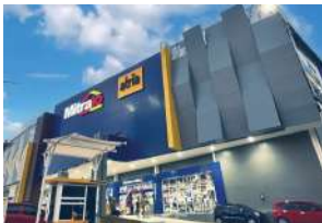
Proyek : Mitra 10 - Tasikmalaya Owner : Catur Sentosa Adiprana Tbk. Maincon : Pratama Adi Jaya Steel
