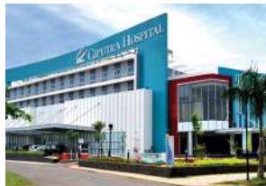
Proyek : Ciputra Hospital Owner : Ciputra Group Maincon : Multikon
