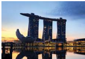
Proyek : Marina Bay Sands Hotel Owner : Las Vegas Sands Corp. Maincon : Ssangyong E & C Co., LTD.
