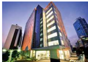
Proyek : Data Center Edge 2 - Jakarta Owner : PT Ekagrata Data Gemintang Maincon : Total Bangun Persada, Tbk
