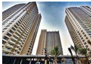
Proyek : Pondok Indah Residence Owner : Metropolitan Kencana Maincon : Total Bangun Persada, Tbk
