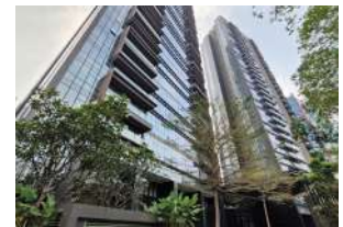
Proyek : Lavie All Suites Owner : Wilson Group Maincon : Total Bangun Persada, Tbk
